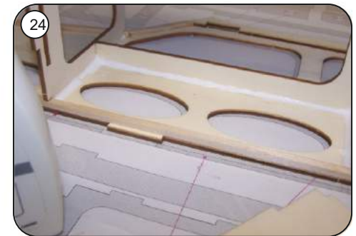
24 Alle Klebestellen nachträglich satt mit Holzleim vermuffen.
