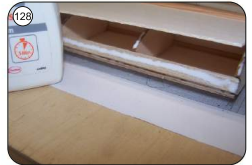
128 Nasenleiste satt mit Holzleim einstreichen.
