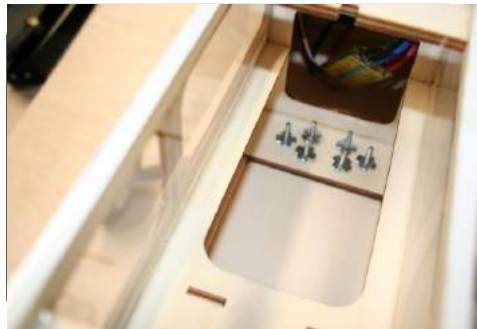
Einschlagmuttern in den Rumpf einsetzen
