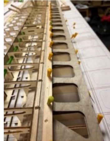
Es folgt nun bereits die obere Ruderbeplankung. Vorderkante der Beplankung ist die Flucht der Pappelleiste der WKL. Die Rudernase wird später, nach dem Abtrennen des Ruders, mit Balsa aufgefüllt und mit Hilfe der Rippenausrundung als Schablone passend geschliffen.
