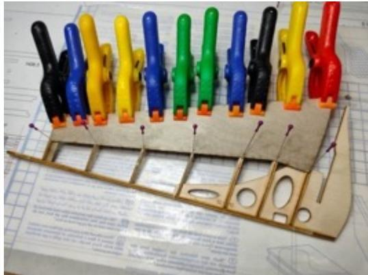
Nach dem Aushärten des Klebers wird die Vorderseite der Beplankung mit der Hilfsnasenleiste bündig geschliffen und anschließend die Nasenleiste aufgeklebt (HL).
