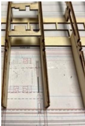
Den Servorahmen für das WKL-Servo zwischen die Rippen R9 und R10 einbauen.
